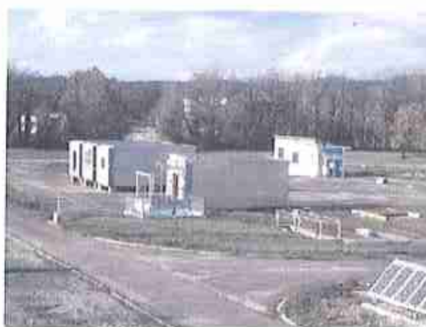
Photo 4 : lieu d'implantation de l'installation
