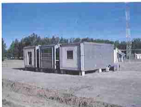
Photo 5 : Dalle bitumée d'implantation de l'installation
